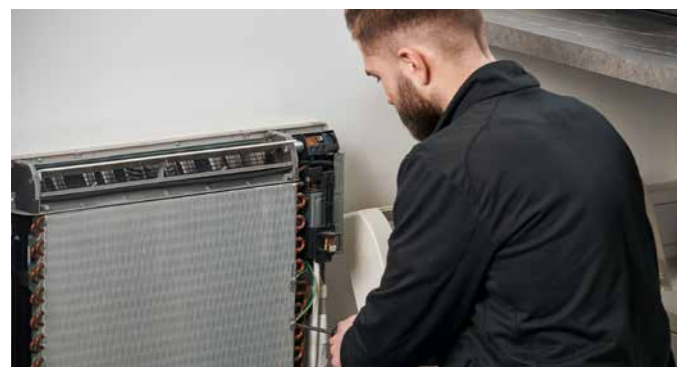
Hygienisch durchatmen: Klimaanlagen
